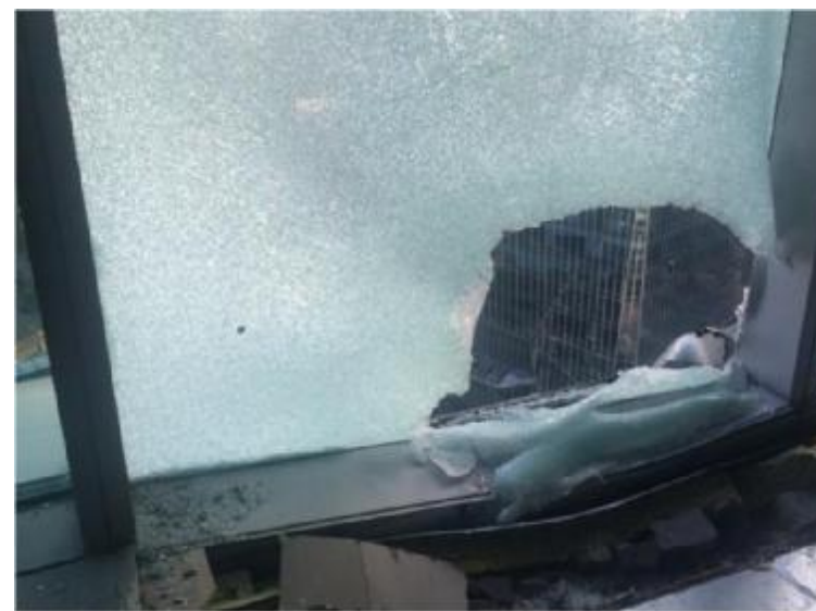
被物体砸毁厚玻璃碎片粘接在胶片上，不飞散
